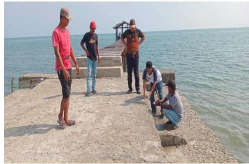
Pembangunan Tambatan Perahu
