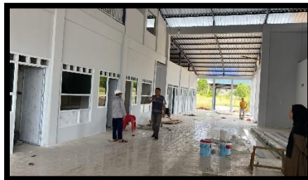
Gambar 3.1 Pembangunan Terminal Malili Tahun 2024
